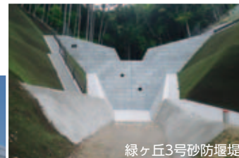
緑ヶ丘3号砂防堰堤
