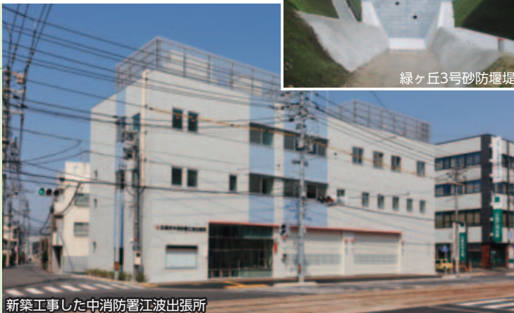
新築工事した中消防署江波出張所
