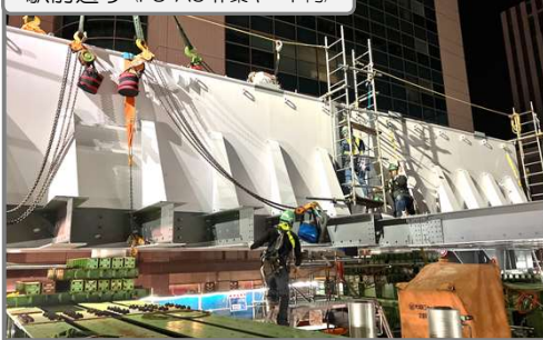
桁の組立作業を行っています
