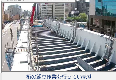
駅前通り (P5-A6 作業ヤード内)
