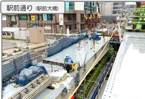
桁架設(電車専用橋 駅方面(上り側) 桁組立作業
