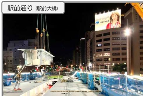
桁架設(電車専用橋) 中床版(中央部)の組立作業
