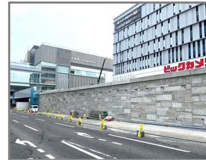
広島駅につながるU型擁壁区間
