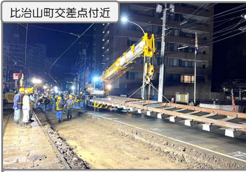
松川町方面への分枝部設置に向けて準備作業中
