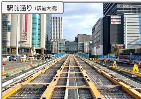
高架部の軌道スラブ整備中
