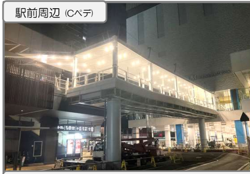
上屋・照明設備施工中(手摺・タイル等 今後整備予定)
