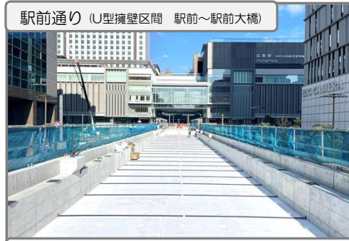
軽量盛土(発泡スチロール)施工中
