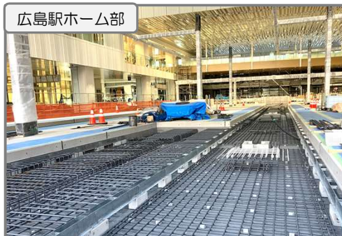
ホーム部の軌道設備施工中
