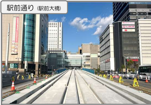
高架部の軌道スラブ整備中
