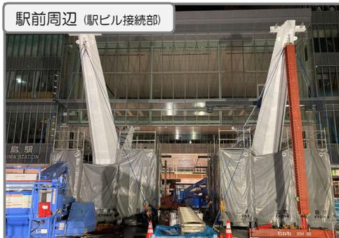
大屋根柱部 架設施工中
