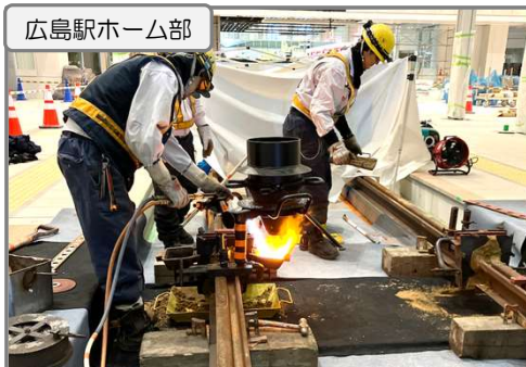
レール溶接作業 施工中
